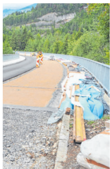
In der Nacht von Dienstag auf Mittwoch wird die Rainbergbrücke gesperrt. EGLE
